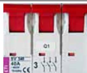
Подайте питание на щит управления при помощи главного выключателя(Q1M). Правильная работа контроллера отображается миганием зеленого светодиода “COMM” на плате управления внутри щита. Система готова к работе сразу после включения.
